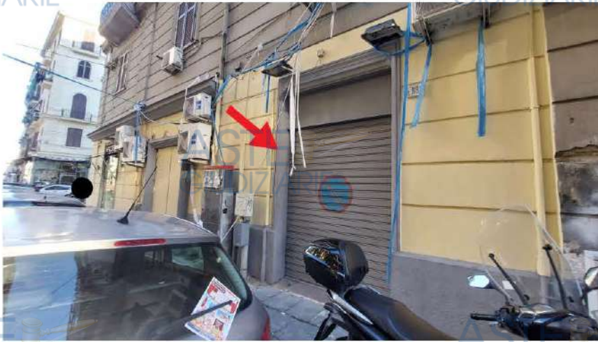
Originario accesso al cespite oggetto di procedura su via Nicola Rocco
