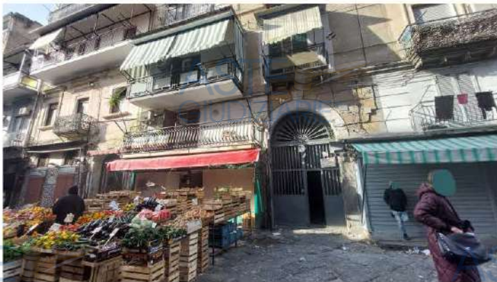
Ingresso al fabbricato
