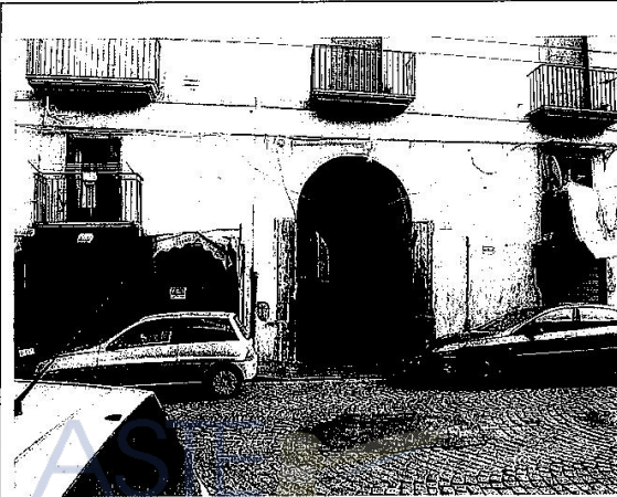
Foto 5 – Ingresso civico n. 898
