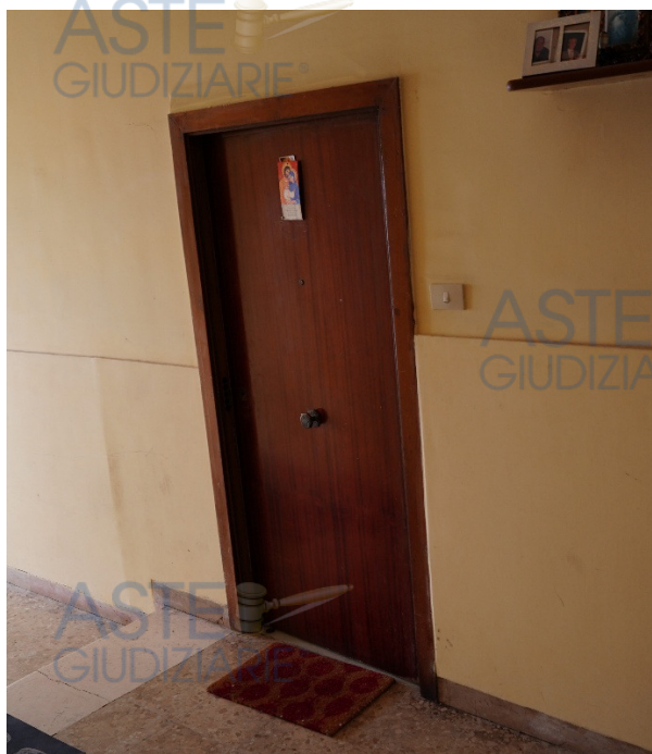
Foto 3 - Porta di ingresso abitazione
