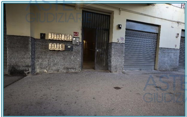
Figura 9 Ingresso "Scala E" dal piano terra (parcheggio)
