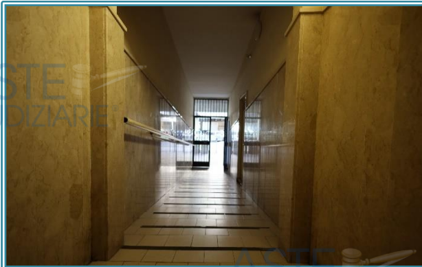
Figura 10 Rampa di accesso che conduce all'ascensore
