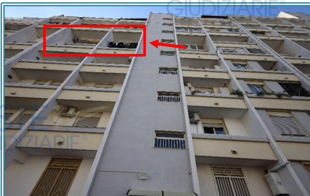
Figura 12 Facciata edificio prospetto est
