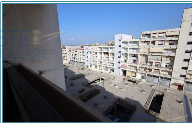
Figura 26 Vista su cortile interno
