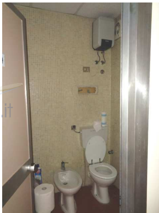
Foto n. 10: • Bagno “cieco” (LOTTO N° 2).
