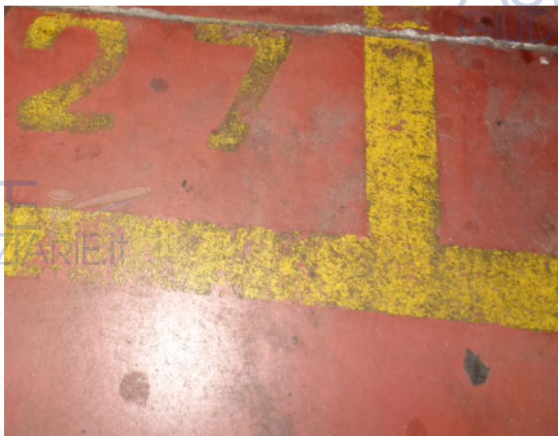
Foto n. 13: • Identificativo dello stallo (pitturato a terra dal lato della corsia di manovra).
