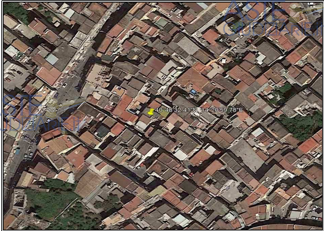
Figura 1 Aereofotogrammetria di Portici con indicazione degli immobili oggetto di causa
