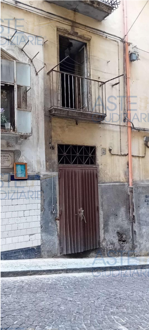
Foto 01 Facciata ingresso su via P.Scura
