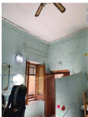
Ingresso/ salotto (si nota la porta di ingresso)
