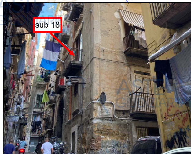
Fabbricato ed immobile interessato
