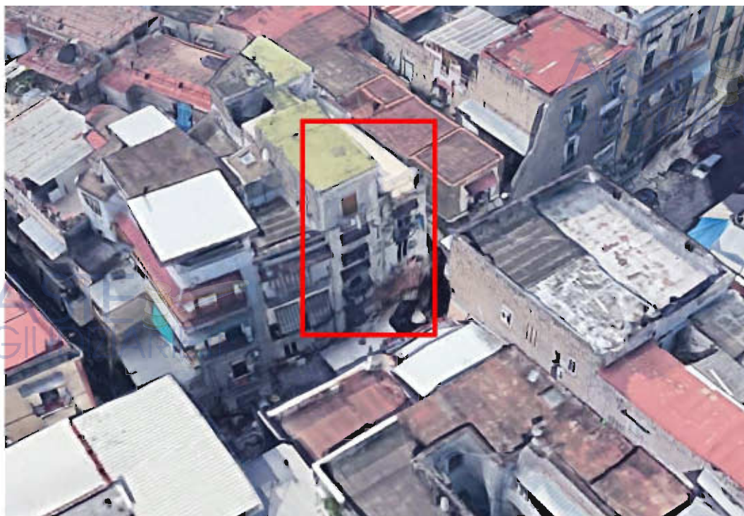
inquadramento territoriale - individuazione fabbricato - prospetto principale prospiciente via Sant'Antonio Abate
