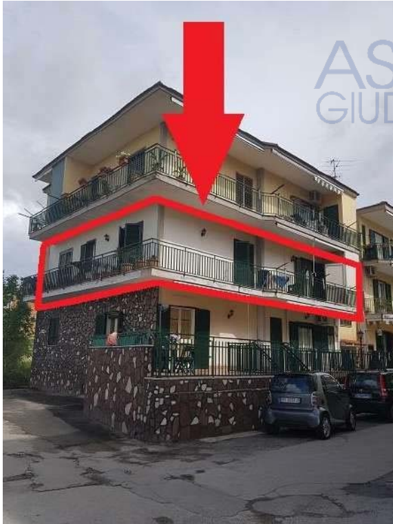
Vista immobile al sub 104
