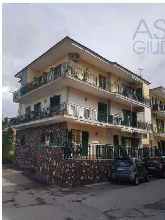
Vista immobile al sub 105
