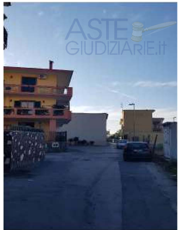
Vista ZONA Casacelle
