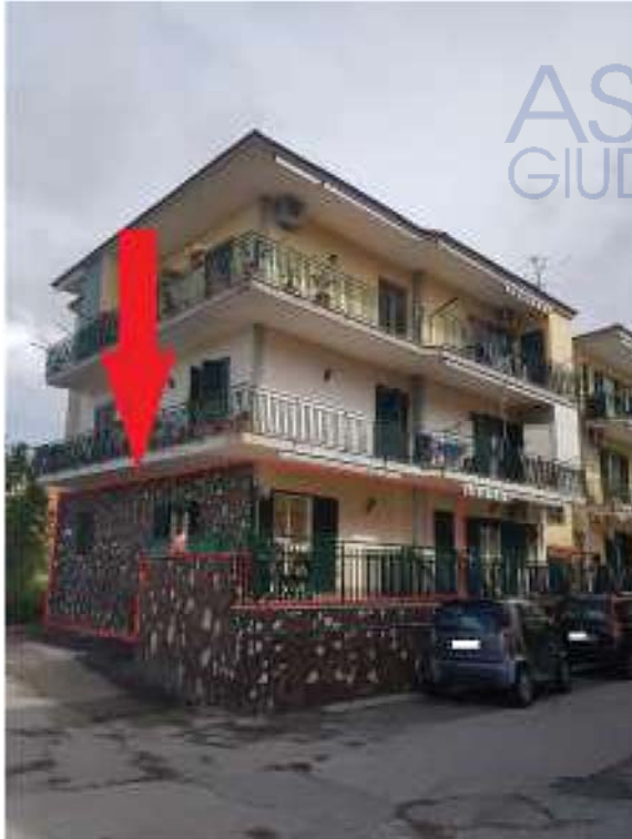
Vista immobile al sub 102
