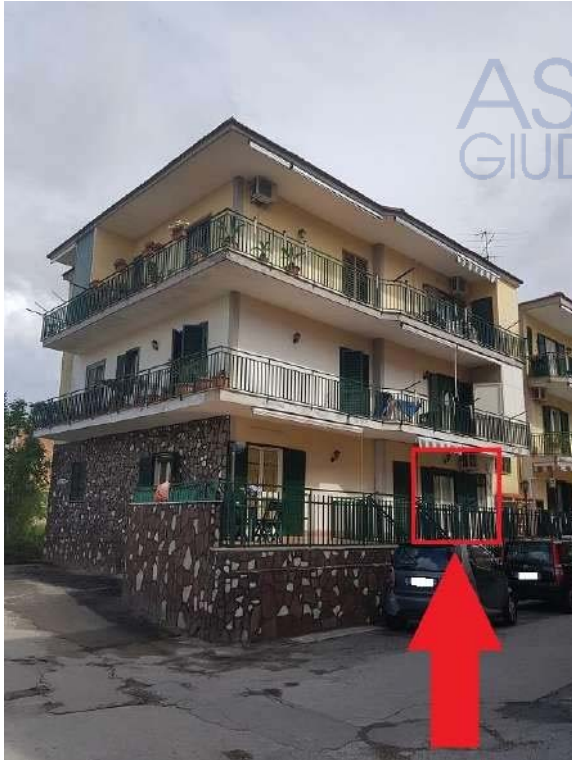
Vista immobile al sub 103
