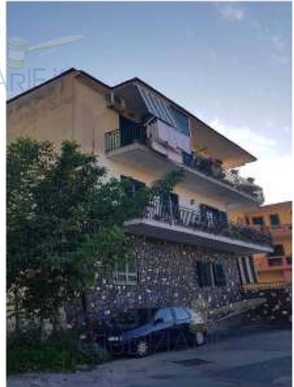
Vista di insieme stabile in cui è allocato il cespite pignorato al piano terra
