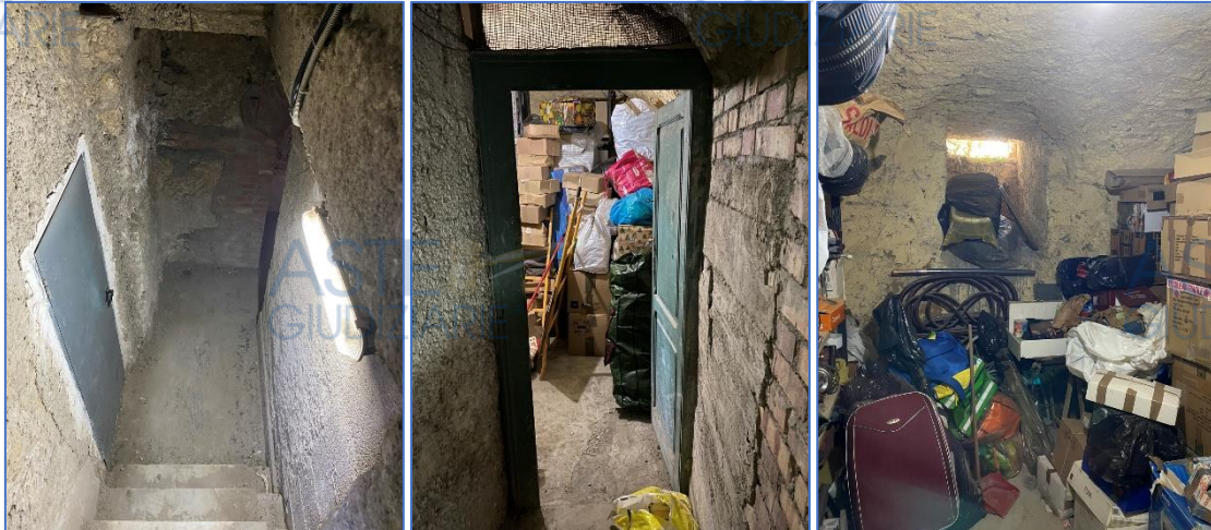
Figura 9. Rilievi fotografici cantinola.
