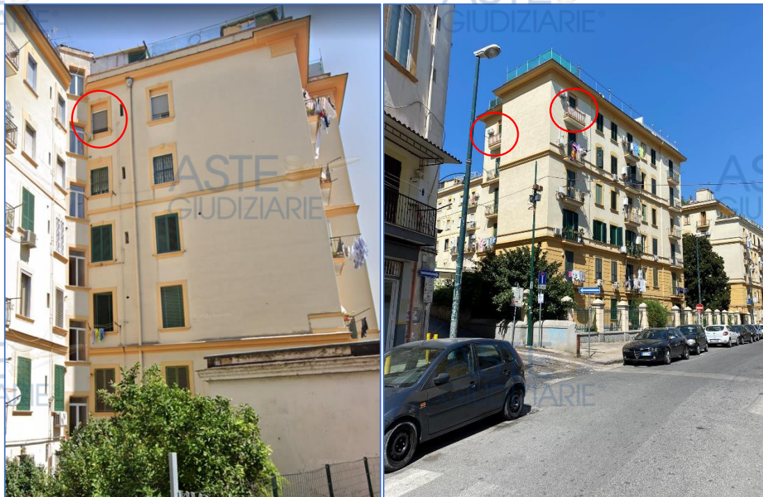
Figura 12. Prospetti del fabbricato con individuazione dei balconi e della finestra non congruenti con la planimetria catastale (il coerente sviluppo delle verticali del fabbricato prova l'erronea rappresentazione della planimetria catastale).
