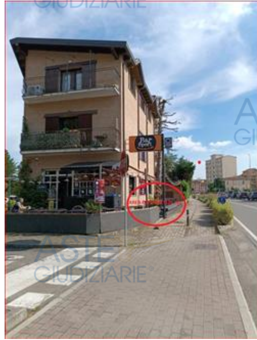
Vista Ingresso Locale Commerciale e Area sub.710
