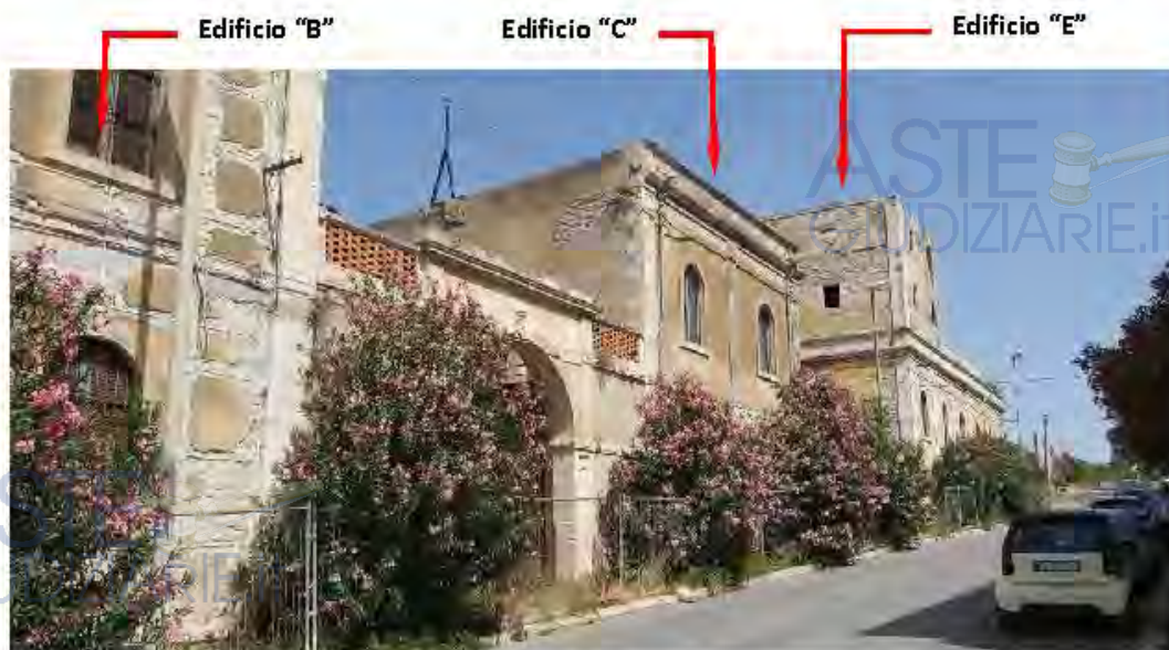
Figura n. 30 : Foto Edificio "C" e Edificio "E" (Foto anno 2022).
