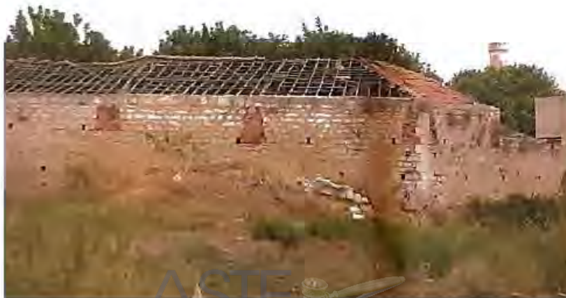
Figura n. 40: Foto Edificio "U" (Foto anno 2011).
