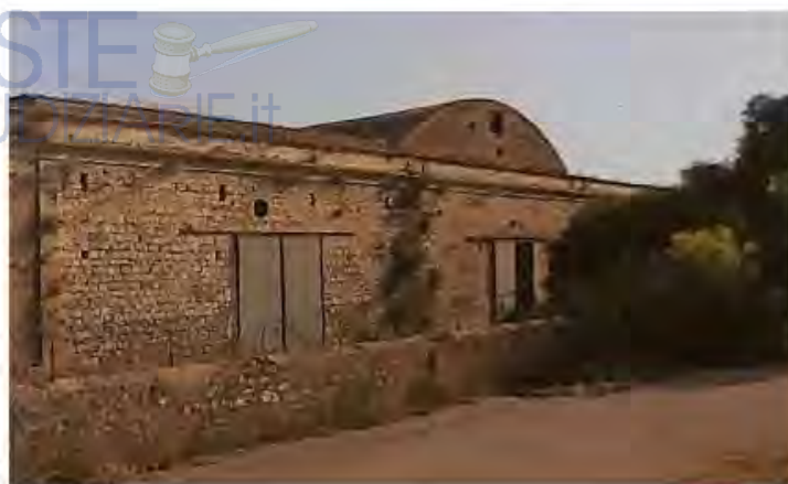
Figura n. 33 : Foto Edificio "M", "N" e "O" (Foto anno 2011)
