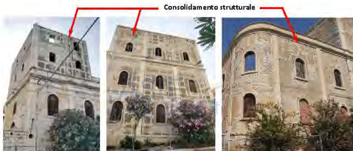
Figura n. 17, 18 e 19 : Particolare dei lavori di consolidamento strutturale.
