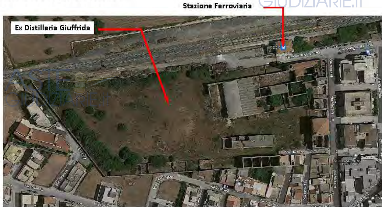
Figura n. 03 : Immagine satellitare dell'intero complesso "Ex Distilleria Giuffrida".
