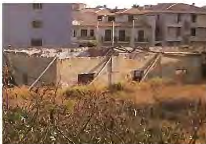
Figura n. 39 : Foto Edificio "T"
