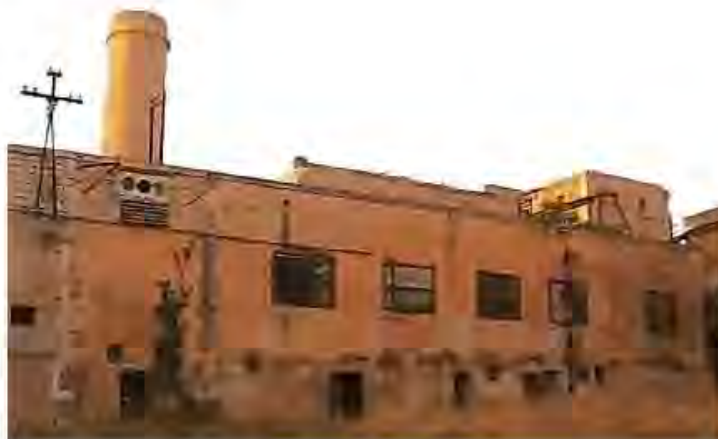
Figura n. 34 : Foto Edificio "G" (Foto anno 2011).
