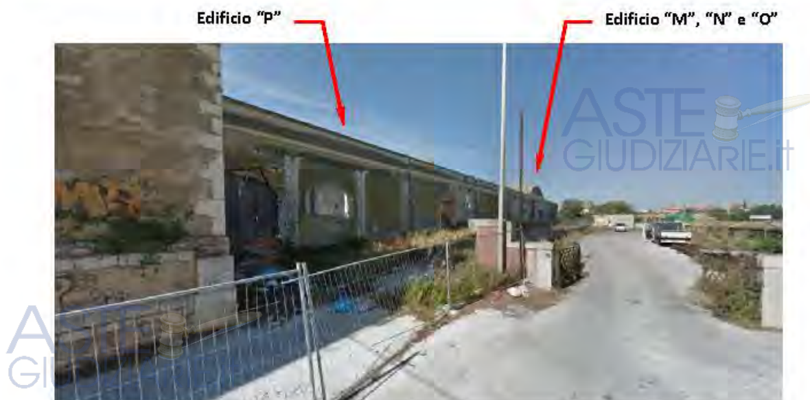
Figura n. 32 : Foto Edificio "P" e Edificio "M", "N" e "O" (Foto anno 2022).
