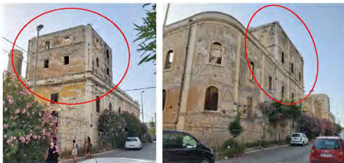
Figura n. 26 e n. 27 : Sopraelevazioni realizzate sul Edificio "E" e sul Edificio "B".
