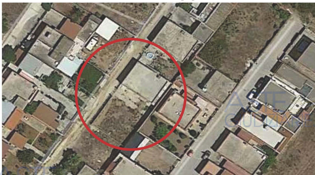
vista part. 146 (fabbricato e terreno)
