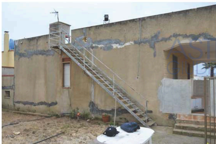
accesso al fabbricato dal terreno comune
