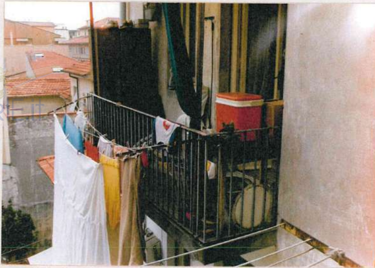
BALCONE APPARTAMENTO PIANO TERZO LATO MONTE
