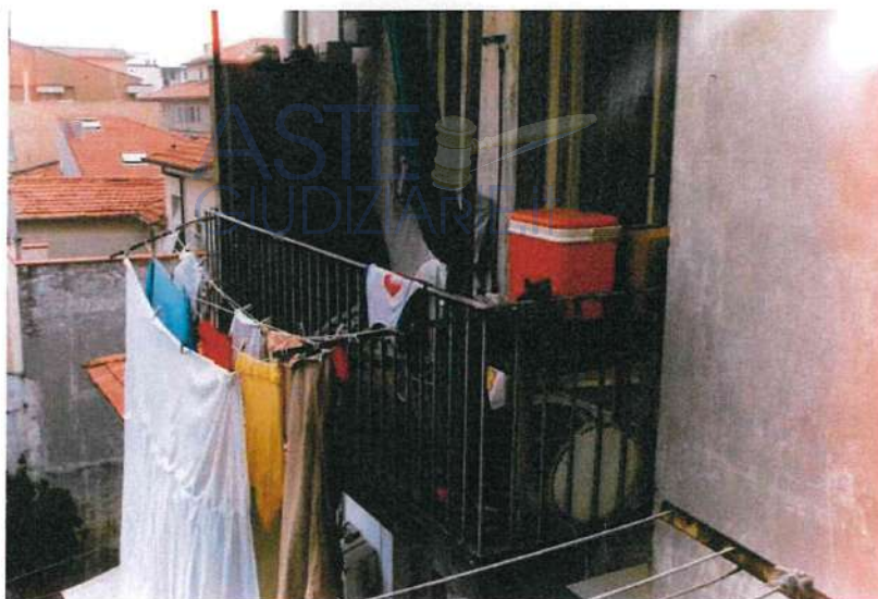
BALCONE APPARTAMENTO PIANO TERZO LATO MONTE
