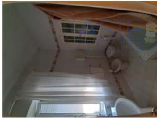
Servizio igienico principale
