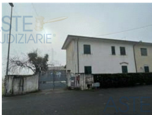
Fronte su via del Paduletto
