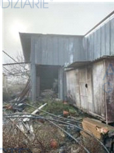
Manufatto in lamiera condonato
