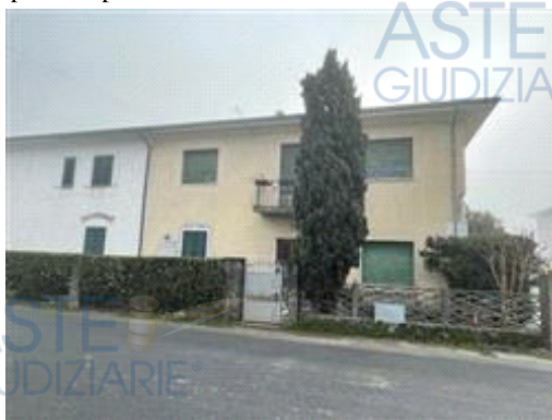
Fronte su via del Paduletto
