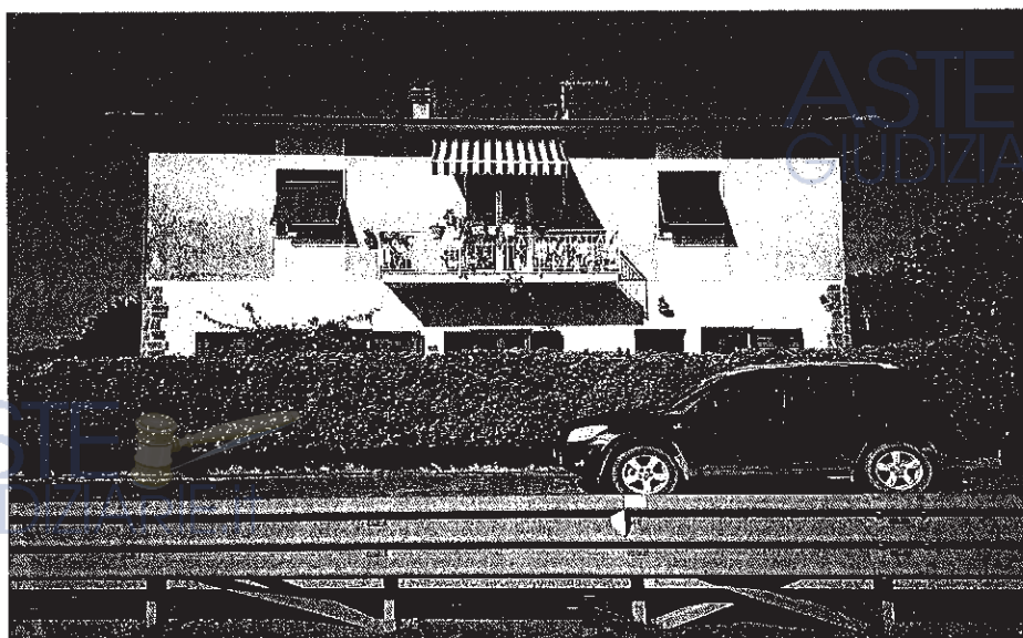
FOTO 1 – Facciata lato via Emilia
