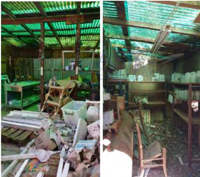
Interno tettoie su piazzale antistante la struttura principale.
