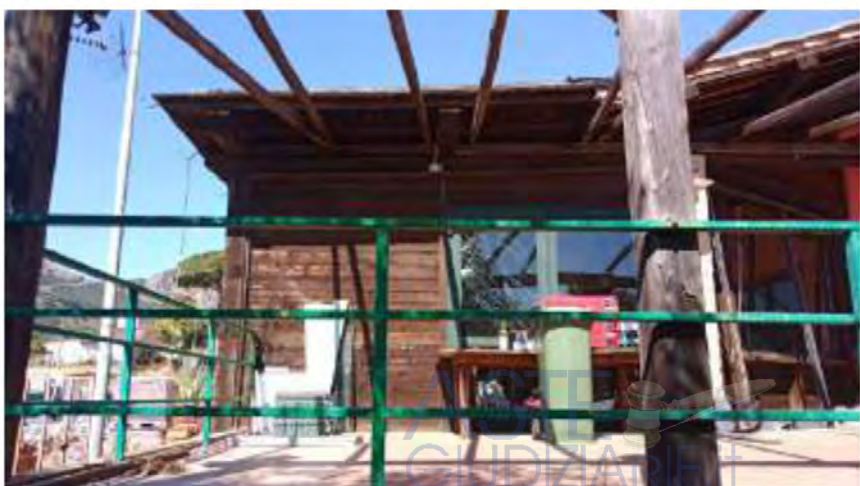
Pergolati esterni zona sud ovest
