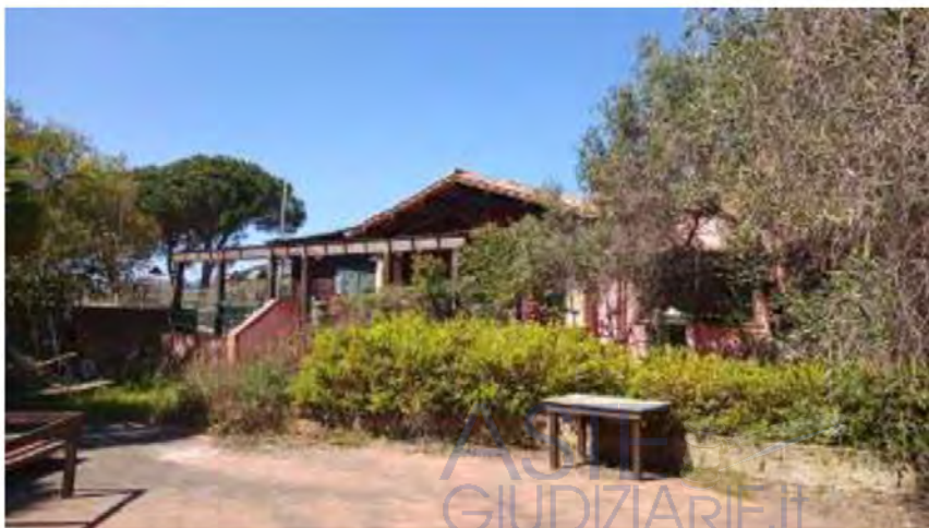
Prospetto lato sud
