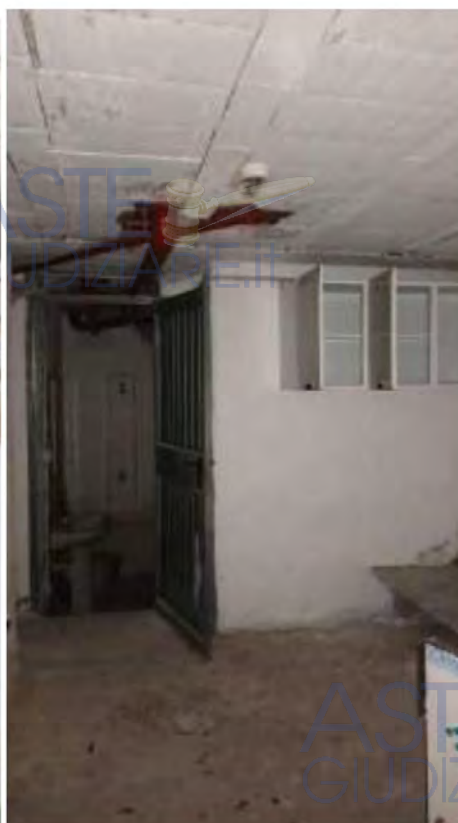
zona interna con servizi
