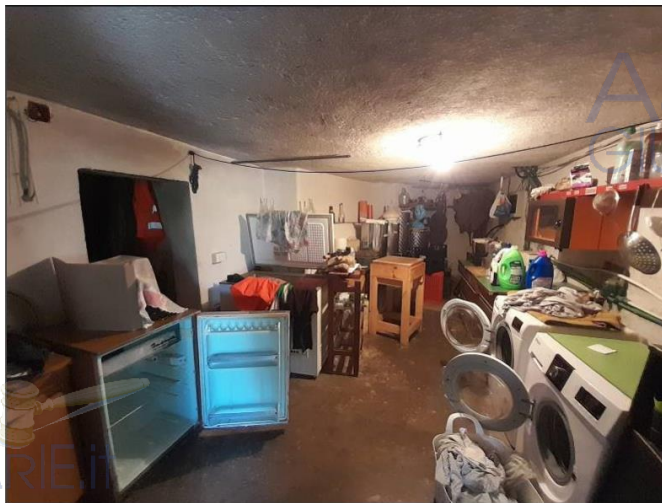
Foto 22 – Locale tecnico interrato sottostante l'appartamento
