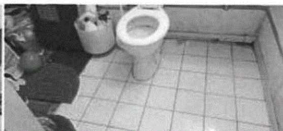
Locale unico con sanitari nel ripostiglio indicato con Rip
