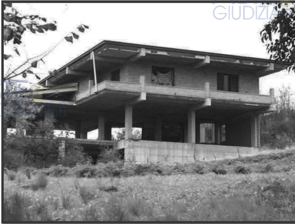
FACCIATA LATERALE DX
