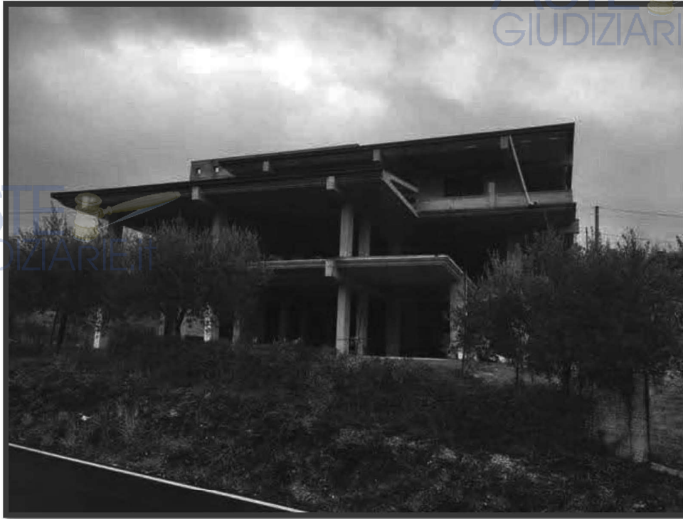
FACCIATA ANTERIORE SULLA EX S.S. 84
