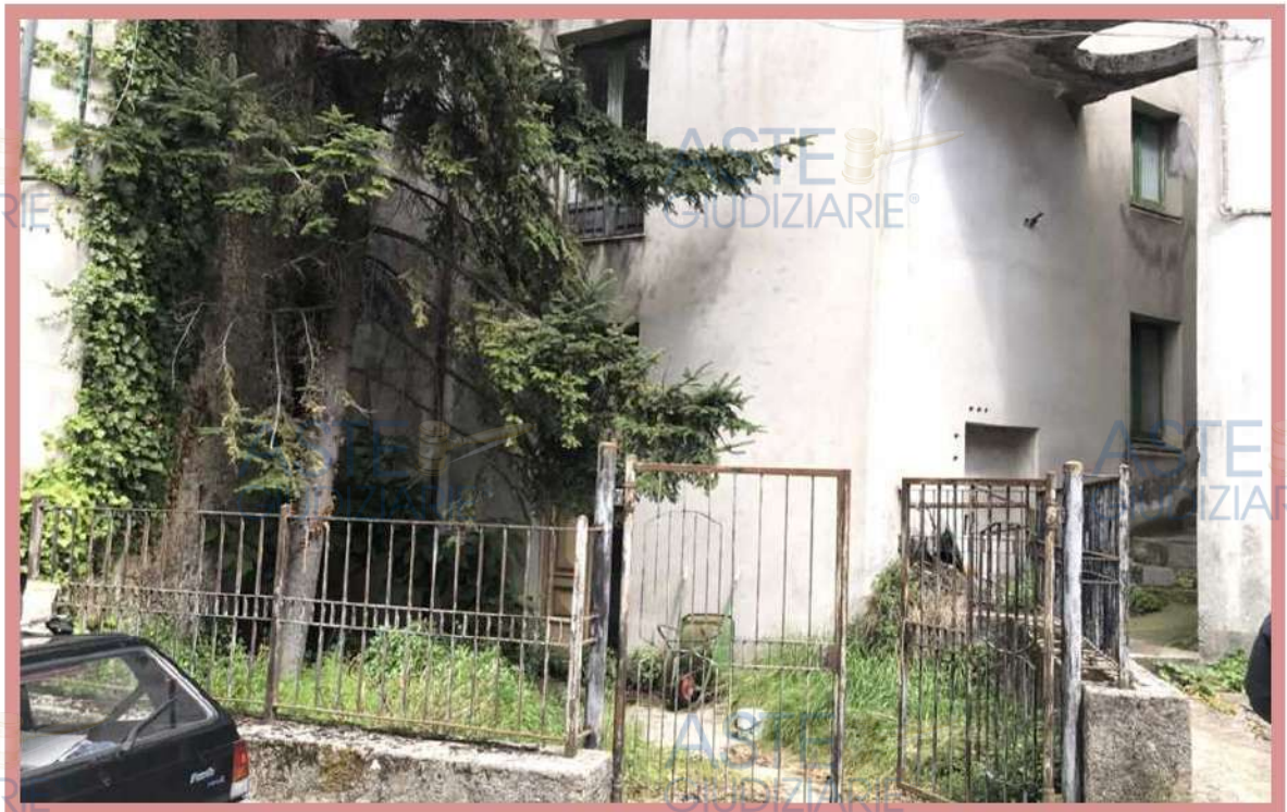
(ingresso da via Cafaro Coperto)
