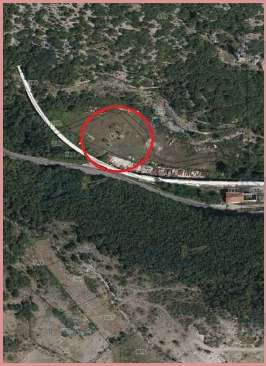
(foto aerea generale con sovrapposizione stralcio catastale estratta da RSDI Regione Basilicata)
