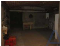
Locali al piano interrato
