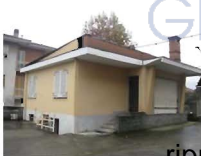
Fabbricato uso ufficio
