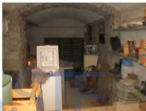
Locali al piano interrato
