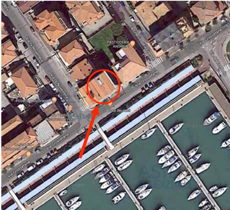
immagine 3 – Via Grossetana, fraz. Marina nel Comune di Grosseto (fabbricato in costruzione)
