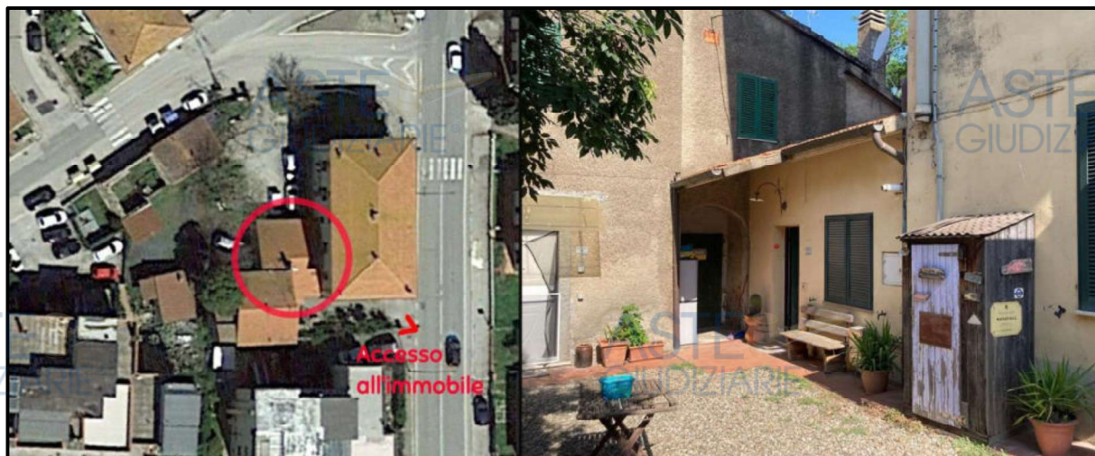
Accesso all'immobile: foto aerea e vista complessiva del fabbricato da Sud-Est
