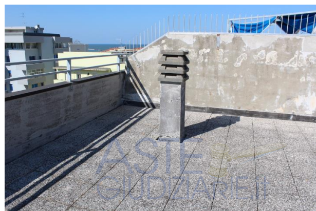
PARTICOLARE DEL PARAPETTO E MURATURA POSTA A DIVISIONE SUL LATO MARE
