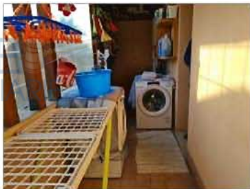
FOTO 49 - PIANO PRIMO RIPOSTIGLIO LA VANDERIA VERANDA NON CONFORME
