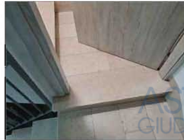
FOTO 60 - VANO SCALA DETTAGLIO INGRESSO PIANO PRIMO
