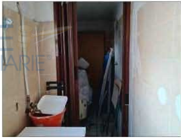
FOTO 34 - VANI NEL FABBRICATO STACCATO A SERVIZI
