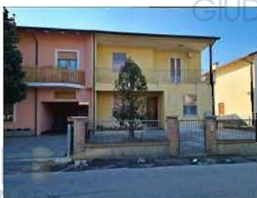
FOTO 11 - VISTA DEL CONFINE DIVISORIO DELLA BIFAMILIARE
