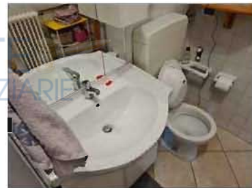
FOTO 51 - PIANO PRIMO BAGNO SECONDARIO NON CONFORME
