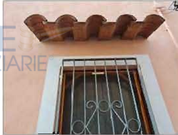
FOTO 65 - FINESTRA A PIANO TERRA CON GRATA ANTI-INTRUSIONE
