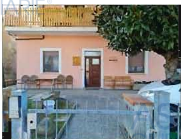
FOTO 10 - CORTILE E INGRESSO PEDONALE
