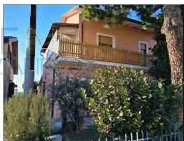
FOTO 08 - PROSPETTO LATERALE E VISTA VERANDA NON CONFORME
