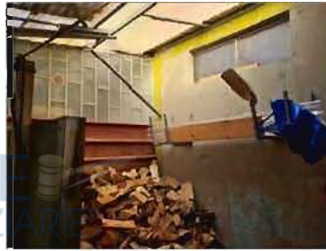
FOTO 32 - AUTORIMESSA A PIANO TERRA
