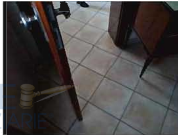
FOTO 59 - PIANO TERRA DETTAGLIO PAVIMENTAZIONI
