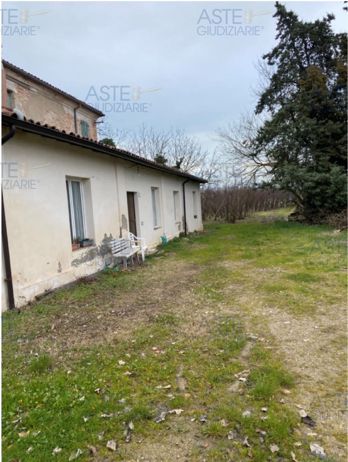
Fot. 16 - Dettaglio del fronte dell'edificio colonico. In evidenza il tamponamento del portico e l'utilizzo dell'unità immobiliare a residenza.
