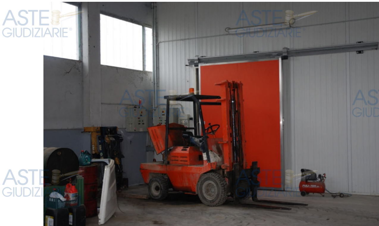
Fot. 9 - Vista dell'interno del capannone agricolo. Si denota con la porta rossa l'ingresso alla cella frigorifera.
