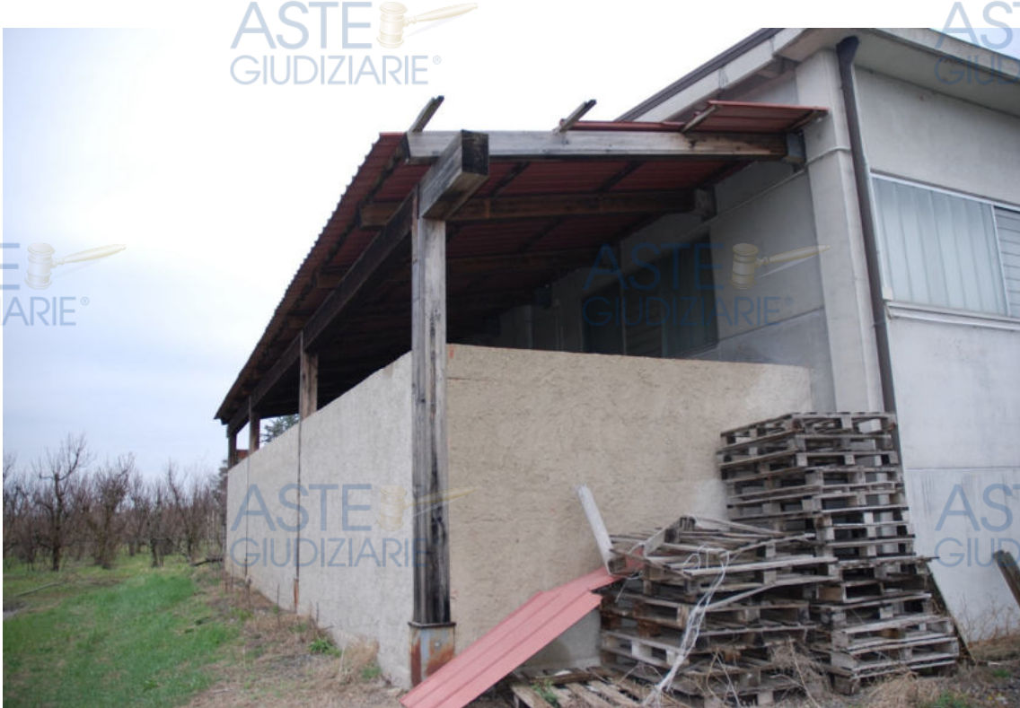
Fot. 6 - Vista posteriore del capannone agricolo.
