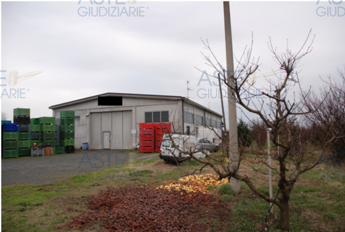
Fot. 4 - Vista prospettica del capannone agricolo.
