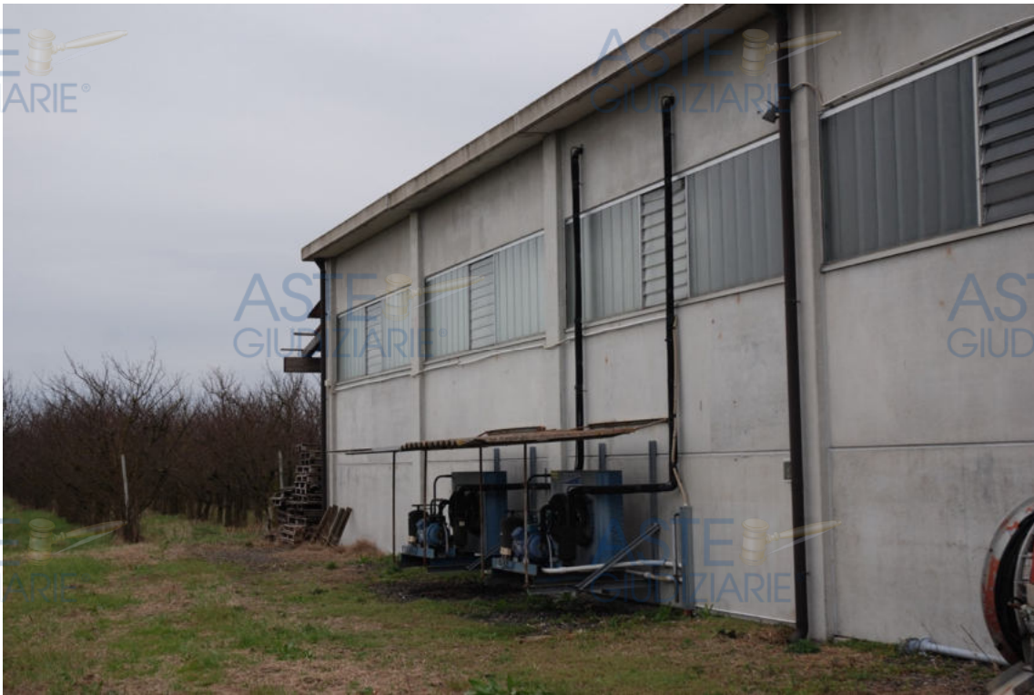
Fot. 5 - Dettaglio della facciata.
