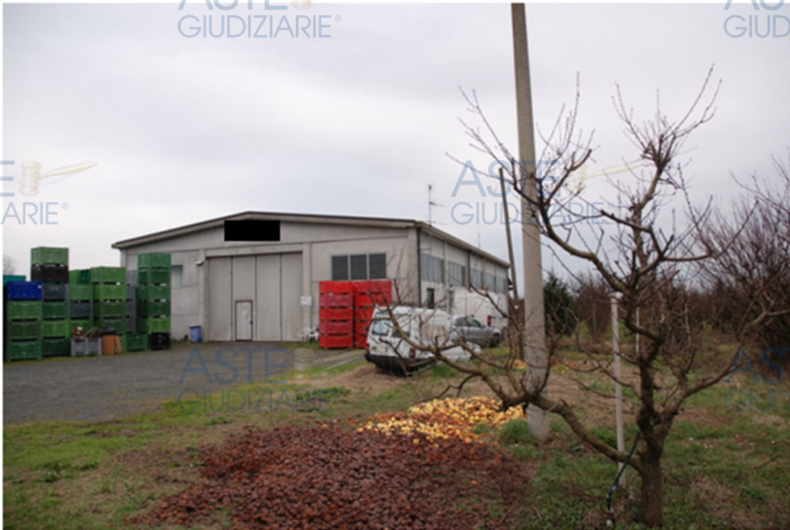
Fot. 4 - Vista prospettica del capannone agricolo.
