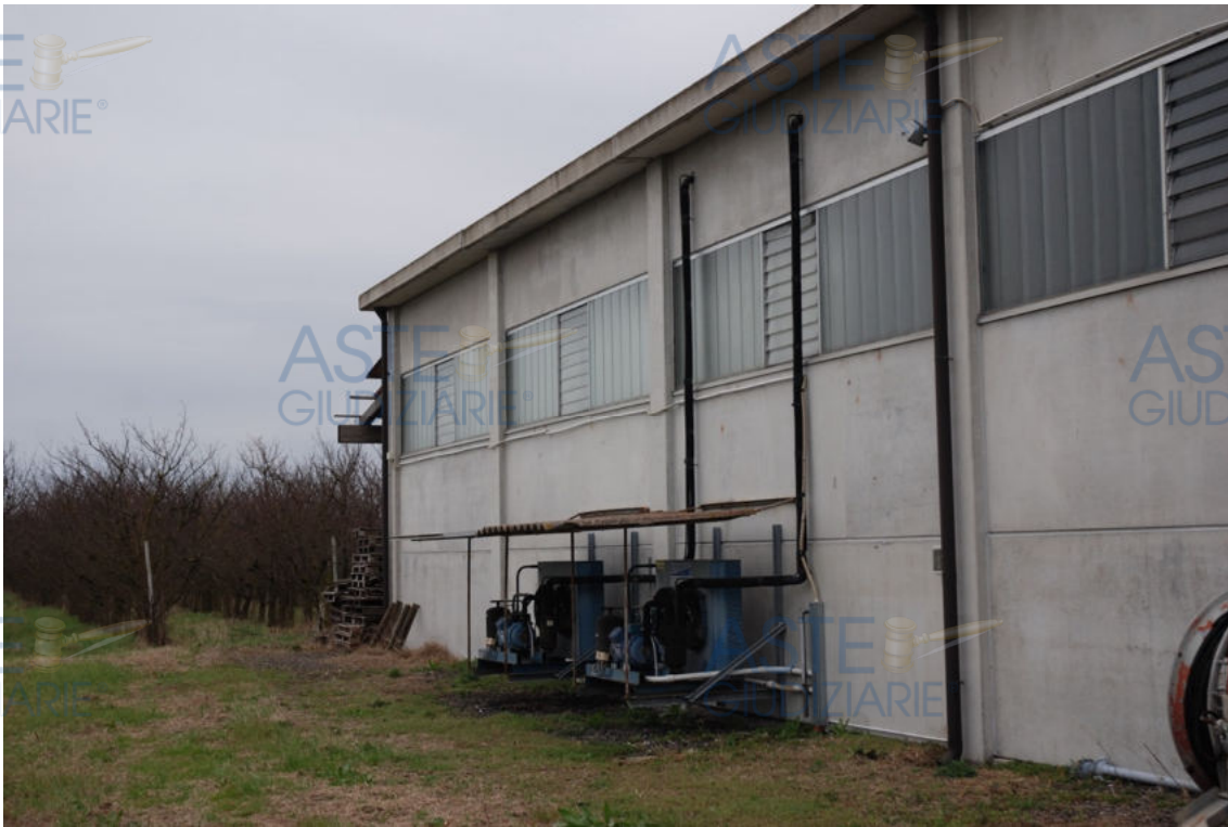
Fot. 5 - Dettaglio della facciata.
