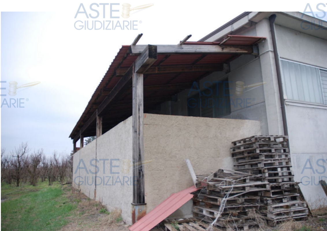
Fot. 6 - Vista posteriore del capannone agricolo.
