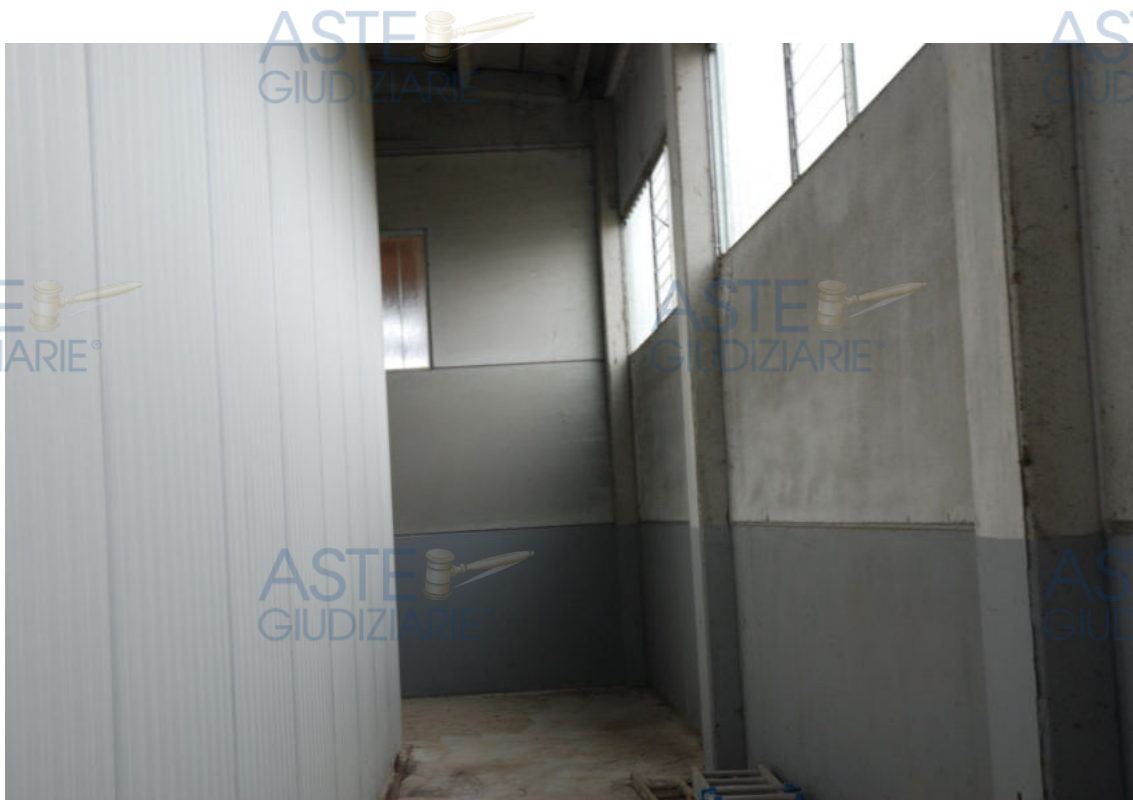
Fot. 10 - Vista del corridoio interno che conduce alla parte posteriore. A sinistra la cella frigorifera.
