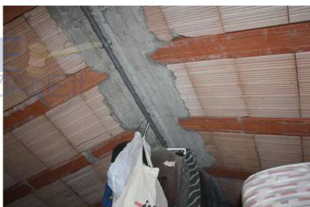
Foto 101: struttura della copertura del proservizio
