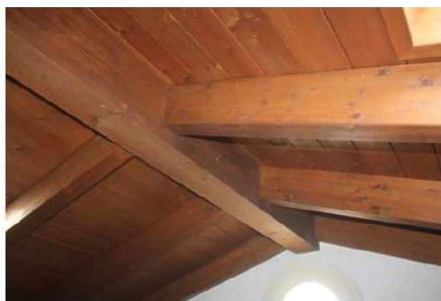
Foto 127: dettaglio struttura copertura
