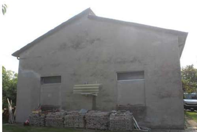
Foto 132: magazzino – prospetto nord
