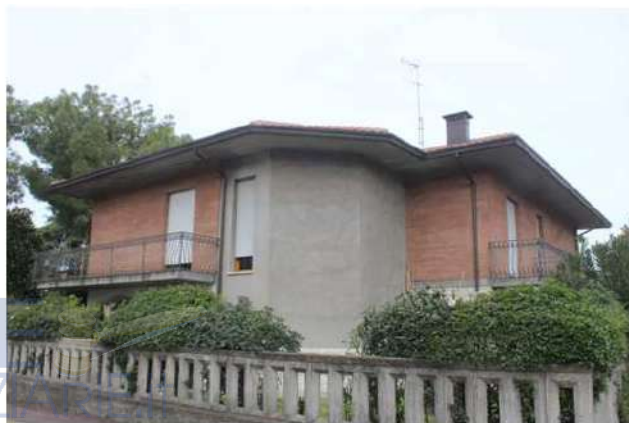
Foto 43: prospetto ovest su via Tagliamento
