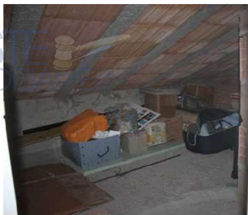
Foto 33: zone di piano terzo non praticabili uso solaio
