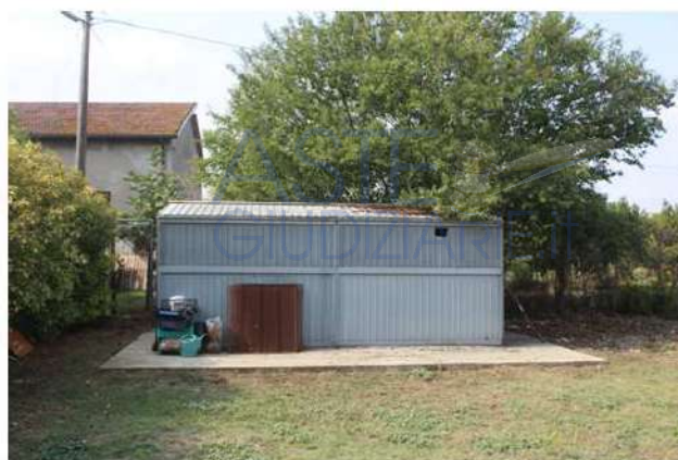
Foto 144: manufatto abusivo nella parte di terreno retro
