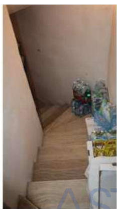
Foto 69: scala di accesso alla cantina
