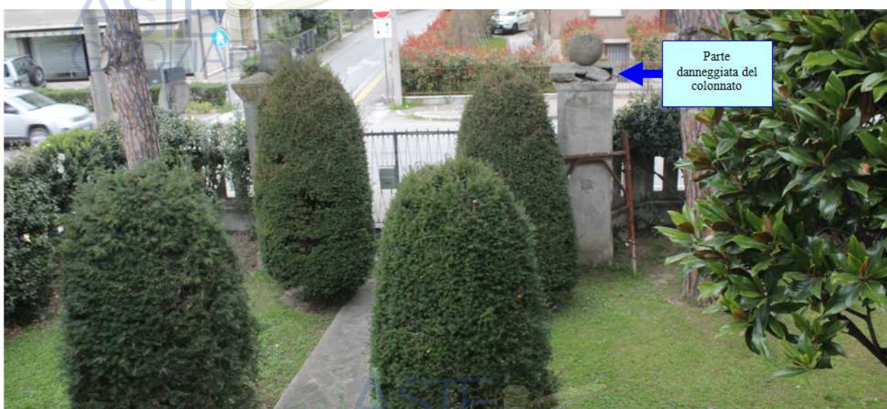
Foto 77: recinzione su via Brenzaglia e giardino – vista dall'interno
