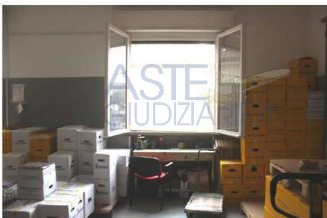
Foto 140: spazio magazzino – particolare infisso
