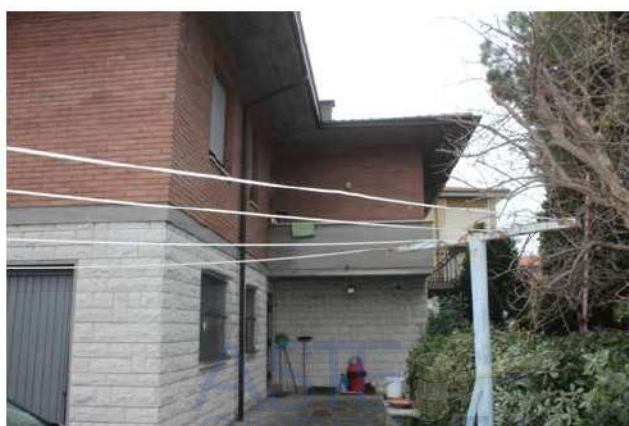
Foto 45: prospetto interno est
