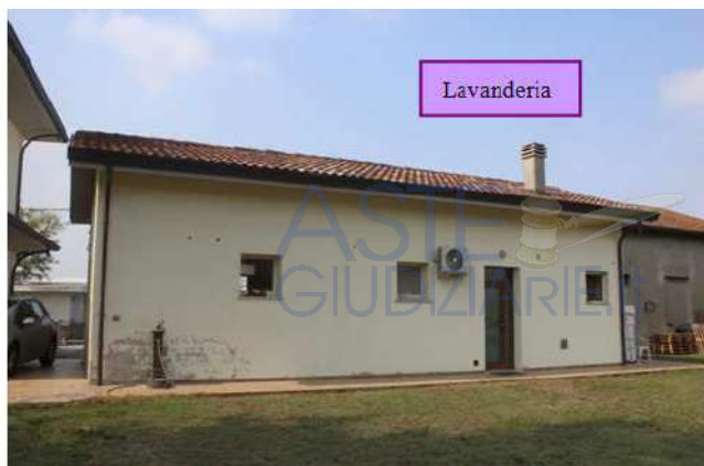
Foto 96: proservizio – prospetto est sul retro
