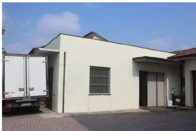
Foto 130: magazzino - prospetto principale sud sulla corte
