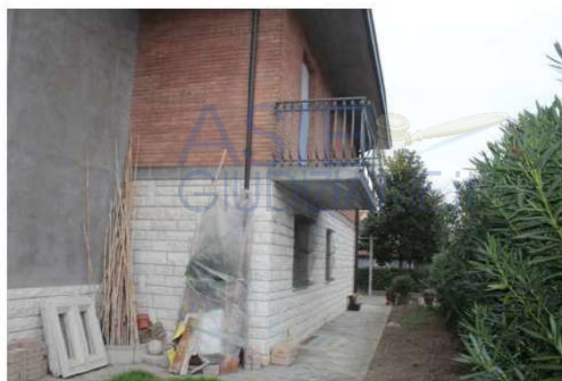
Foto 75: giardino lato via Isarco
