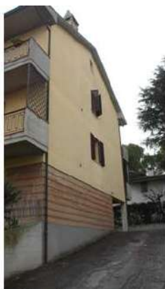
Foto 3: prospetto laterale nord
