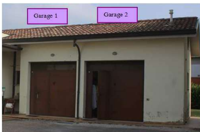
Foto 95: proservizio – prospetto principale ovest sulla corte
