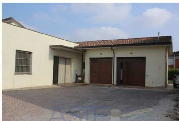
Foto 84: corte pavimentata tra edificio abitativo, proservizi e magazzino
