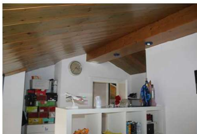
Foto 31: dettaglio andamento copertura
