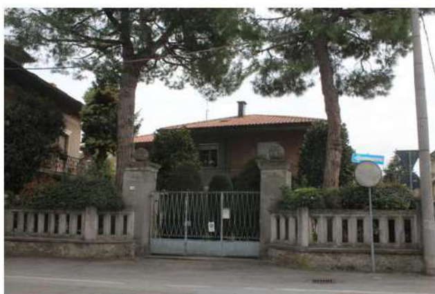
Foto 44: prospetto principale nord su via Brenzaglia
