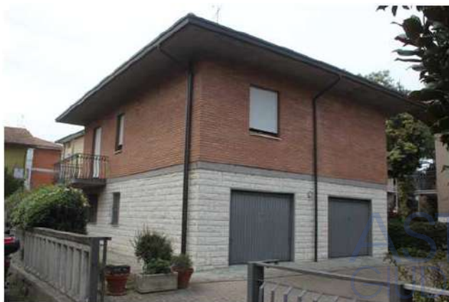
Foto 42: prospetti est e sud su via Isarco
