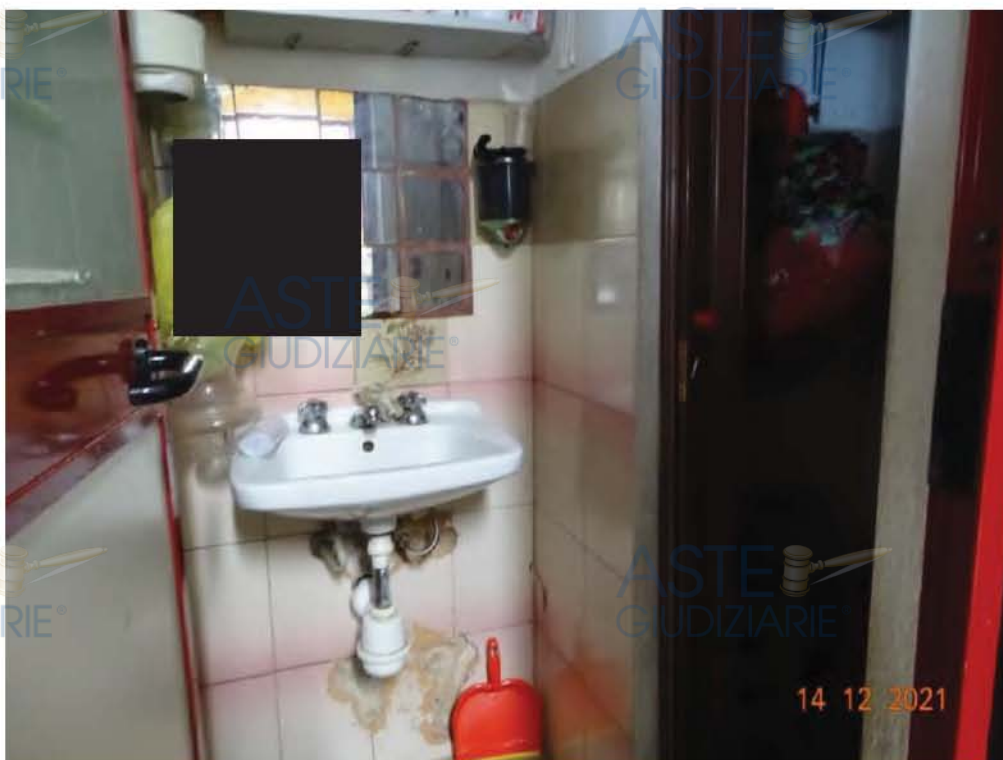
Foto 13 – Particolare del piccolo servizio igienico immobile “B”
