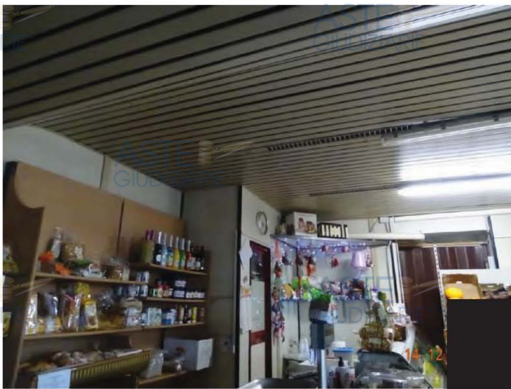
Foto 11 – Vista interno immobile "B"
