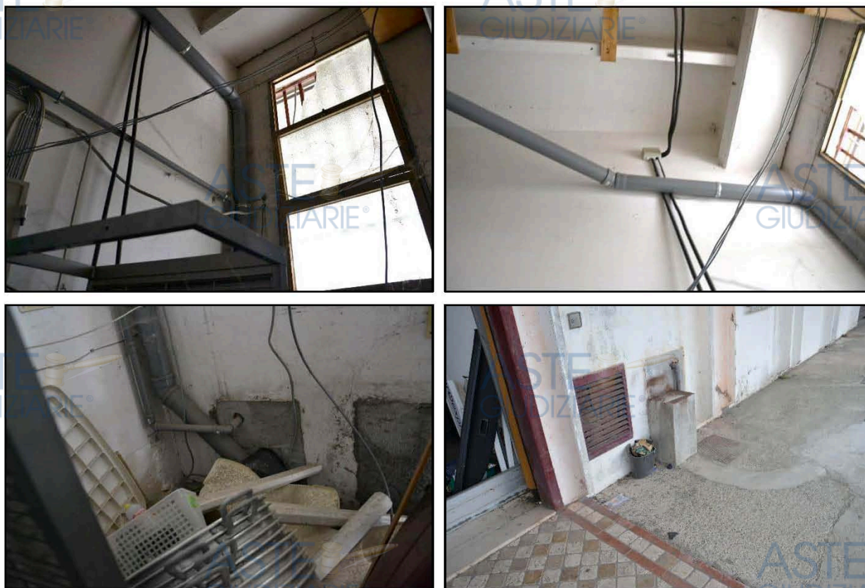
Figura 14 - Servitù tubazione di scarico
