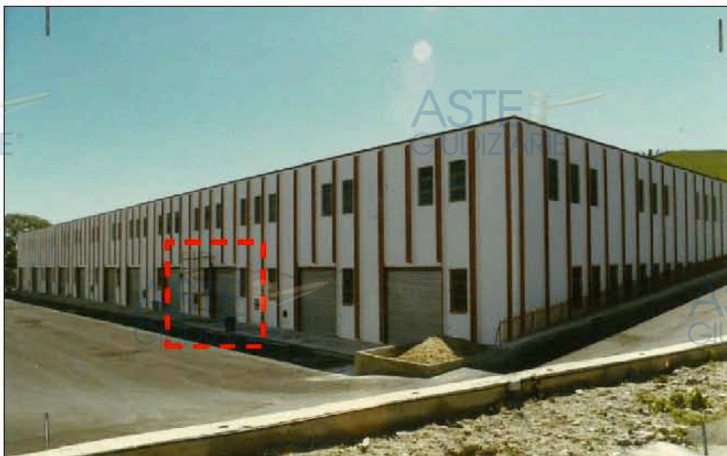
Figura 25 - Documentazione fotografica allegata all'istanza di condono di cui alla Concessione Edilizia in Sanatoria n.22983 del 15/03/2012
