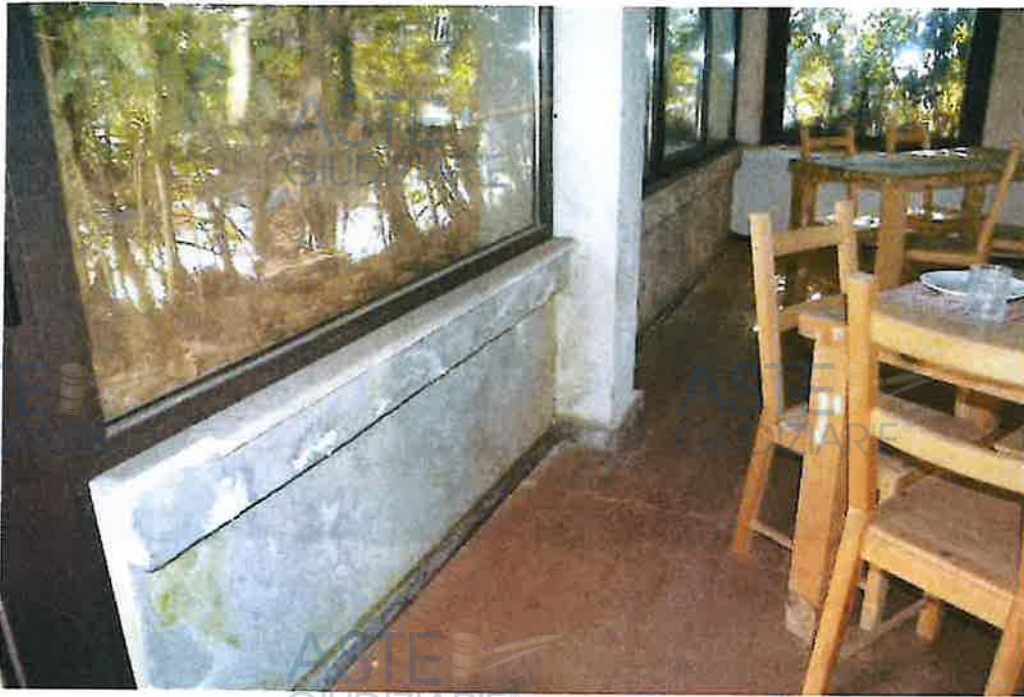
Foto 13: particolare del muro del porticato
