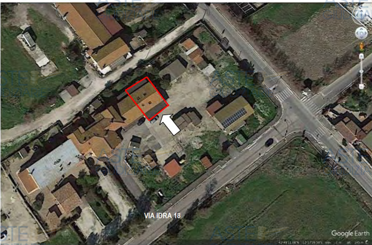
Figg. 5-6 - Individuazione del compendio nel Comune di Fiumicino lungo Via Idra: Unità Sub. 1 di fabbricato ubicato su p.lla 35 - fonte Google
