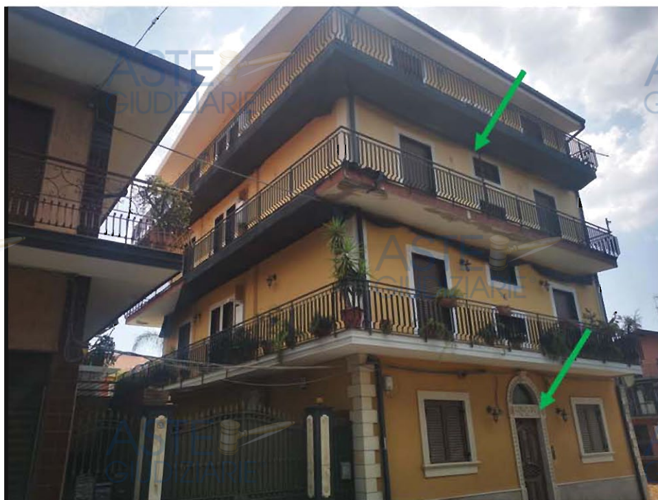
Figura 7- Visualizzazione dell'edificio condominiale e dell'ingresso al vano scala dello stabile condominiale
