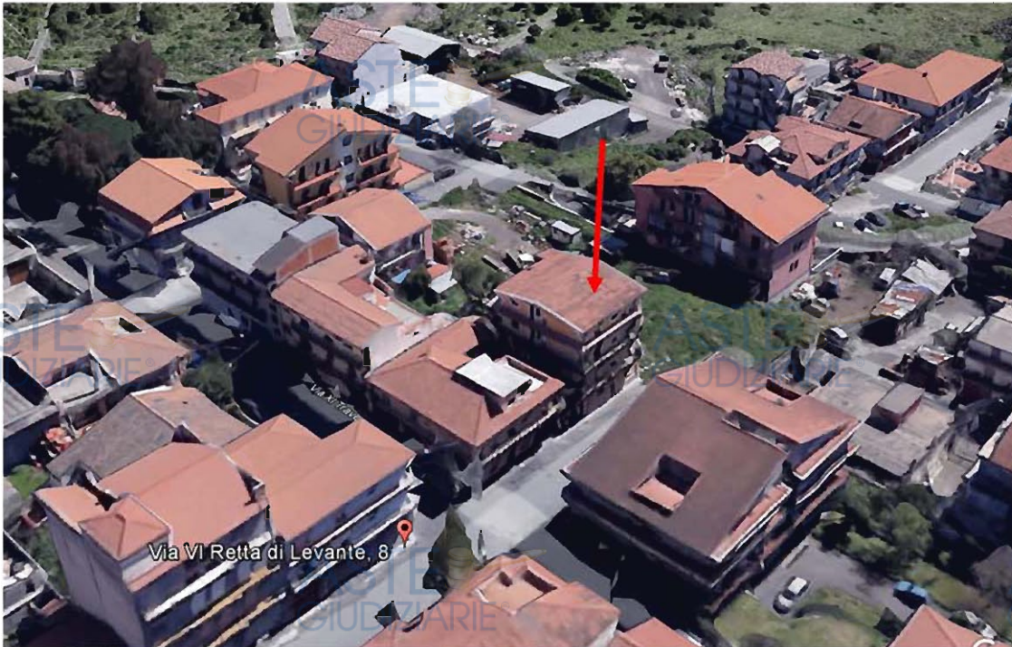
Figura 3- Visualizzazione satellitare ingrandita dell'edificio su cui insiste l'immobile oggetto di valutazione
