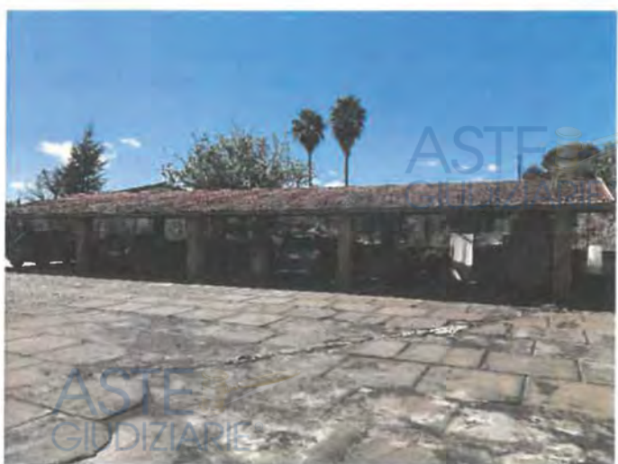
Tettoia Posti Auto
