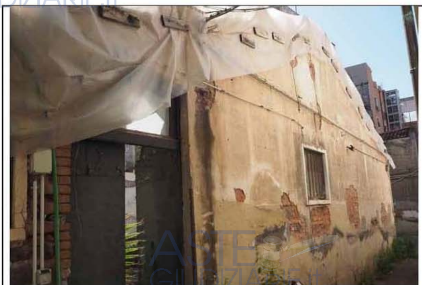
foto n° 11: Vista di una parete esterna del vano demolito
