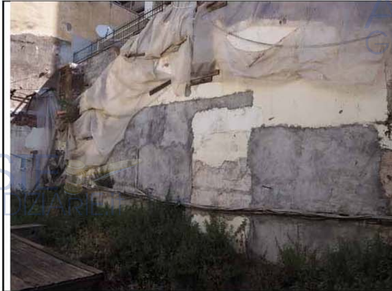
foto n° 13: Parete del vano demolito confinante con il negozio
