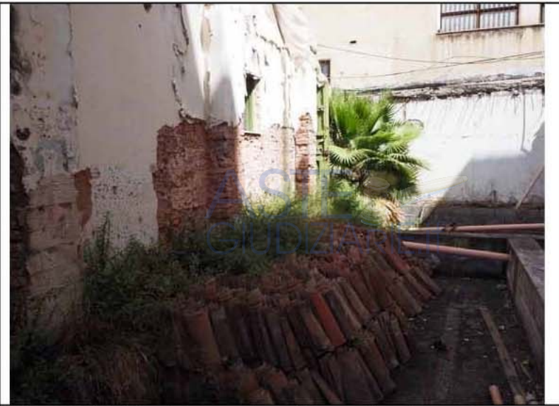
foto n° 14: Vista del vano demolito confinante con il negozio
