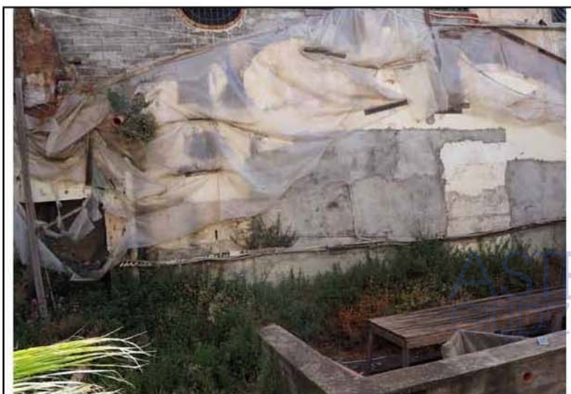
foto n° 12: Parete del vano demolito confinante con il negozio
