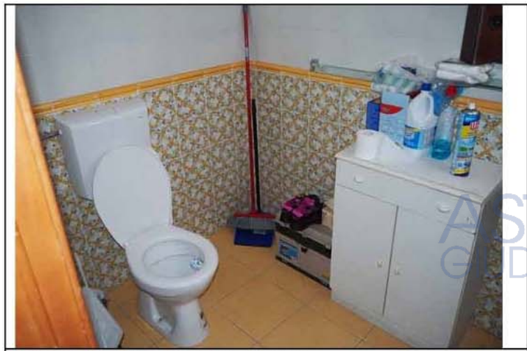
foto n° 21: Vista del vano bagno
