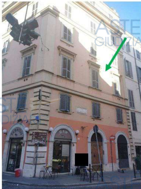
Figura 6- Visualizzazione dell’edificio condominiale e dell’immobile oggetto di valutazione
