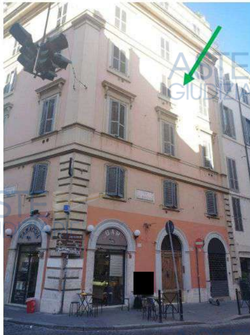
Figura 16- Visualizzazione dell'edificio condominiale e dell'immobile oggetto di valutazione
