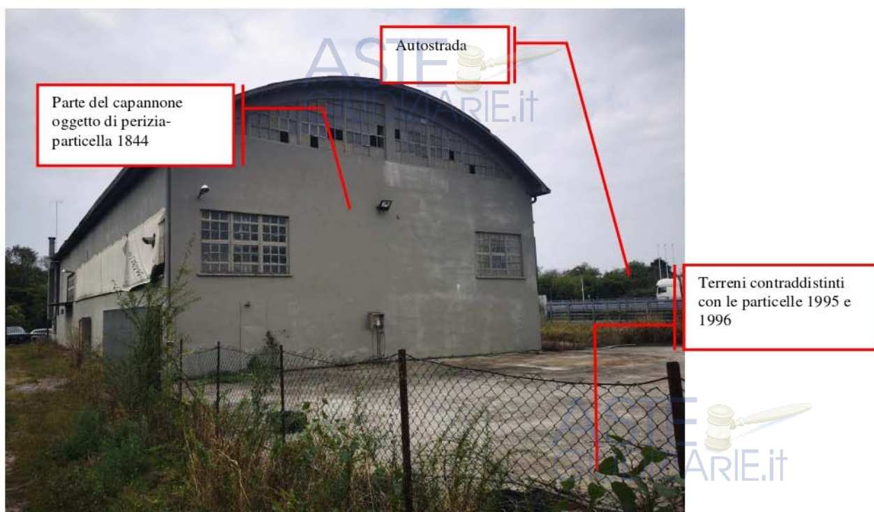
Figura 44- Visualizzazione della parte di capannone oggetto di valutazione
