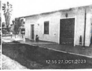
Foto 2 - Edificio "A" prospetto nord
