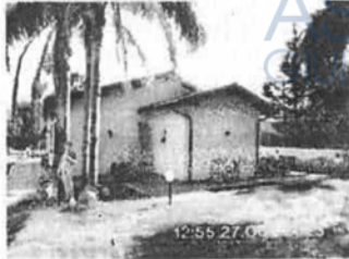
Foto 3 - Edificio "A" prospetto ovest
