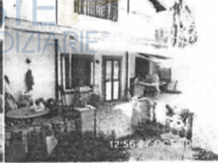
Foto 4 - Edificio "A" piano -1 prospetto est
