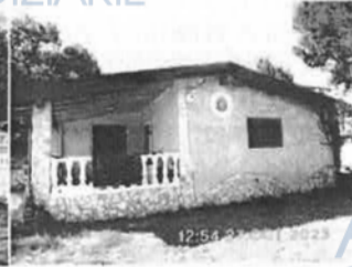
Foto 6 - Edificio "B" prospetto est
