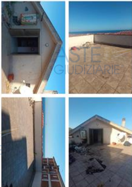
ESSEZIO IMMOBILIARE N. 129/2023 R.G.E. DEL TRIBUNALE DI CASTROVILLARI - CTU ING. DOMENICO STELLA - RILIEVO FOTOGRAFICO ESTERNO (TERRAZZO) DEL PIANO QUARTO MANSARDATO NON ABITABILE DELL'APPARTAMENTO IN VIA CASSICOORO E IN CASATI MARINA (CS).
