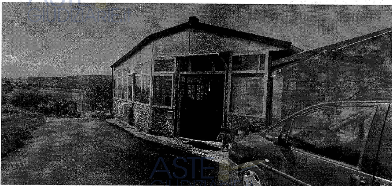
Foto 1: Parte realizzata in aggiunta alla particella 571 sub 2.
