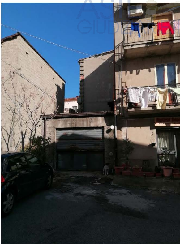
Esterno Prospetto Sud-ovest
