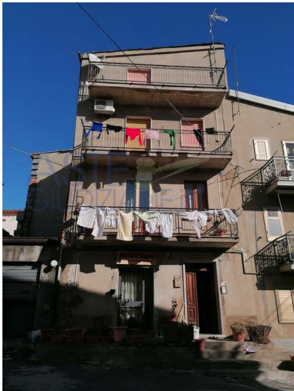
Esterno Prospetto Sud-ovest
