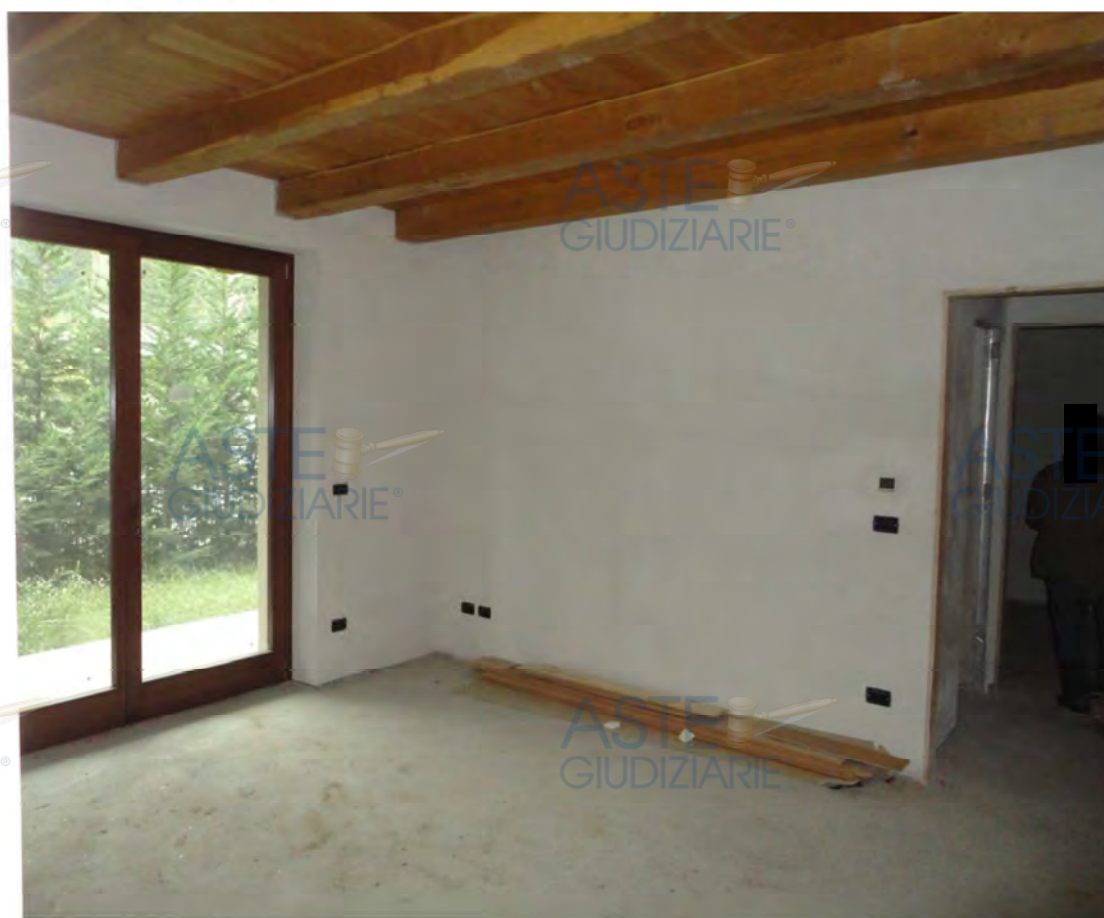
Residenza Argentera - interno alloggi
