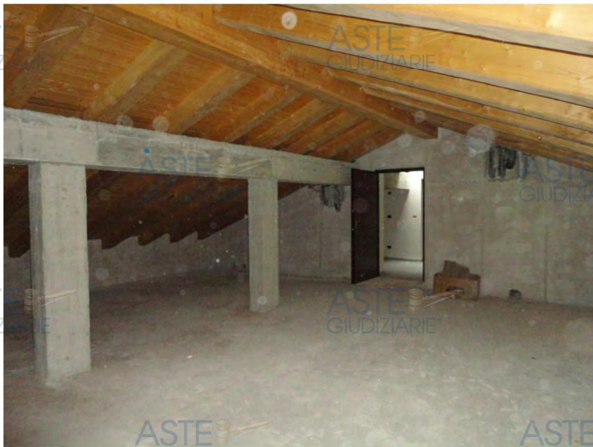
Residenza Argentera – interno sottotetto
