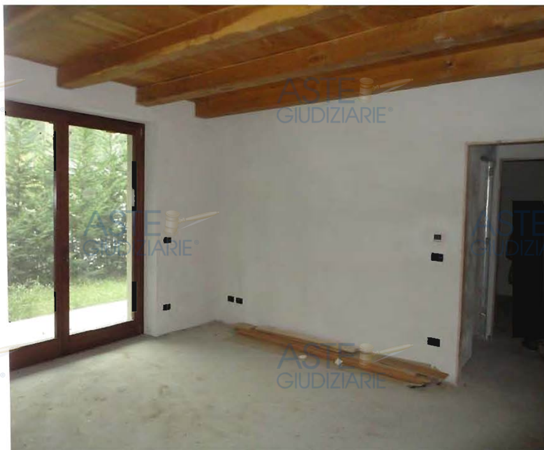
Residenza Argentera - interno alloggi
