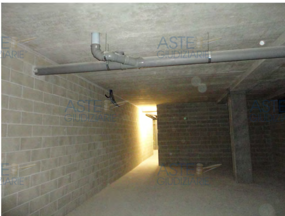
Residenza Belvedere - interno magazzino
