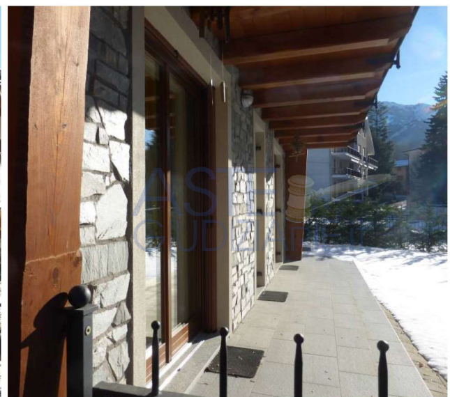
Particolare zona verde esclusiva
