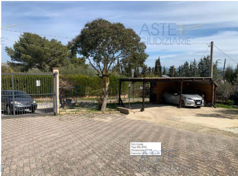
Foto 18 Piazzale e Tettoia
