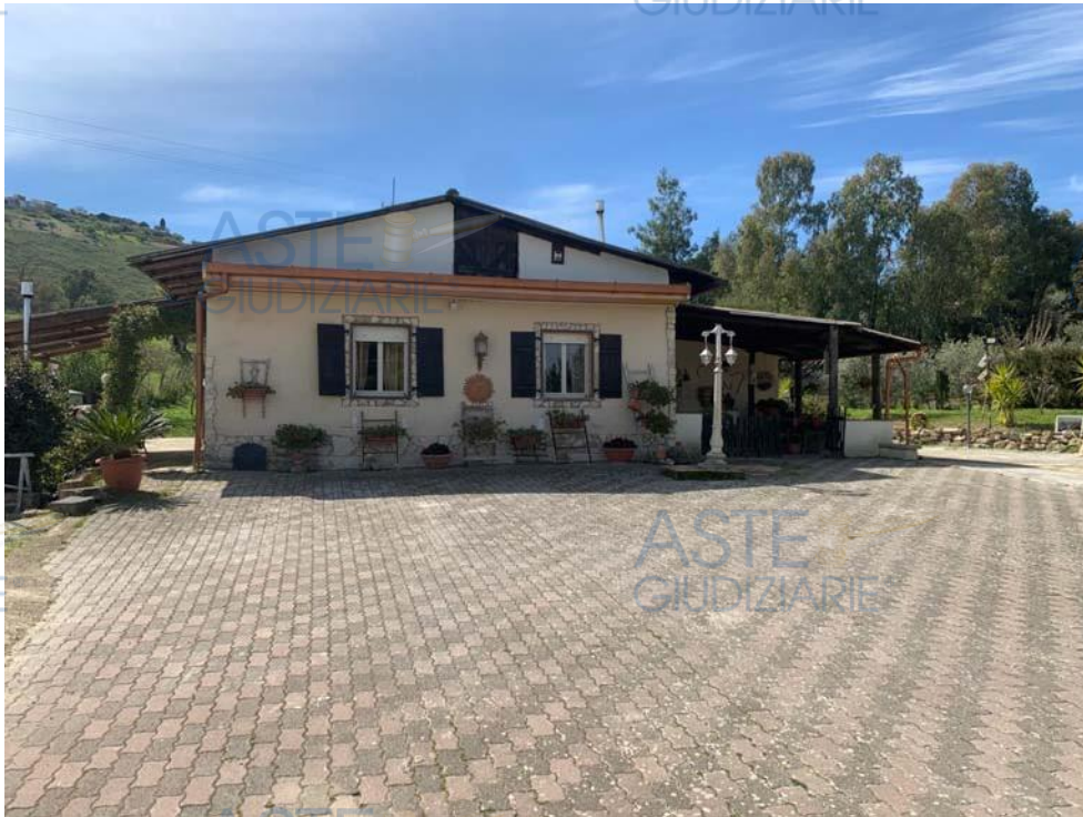
Foto 1 Prospetto lato ingresso
