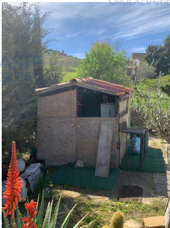
Foto 15 Locale tecnico in precario
