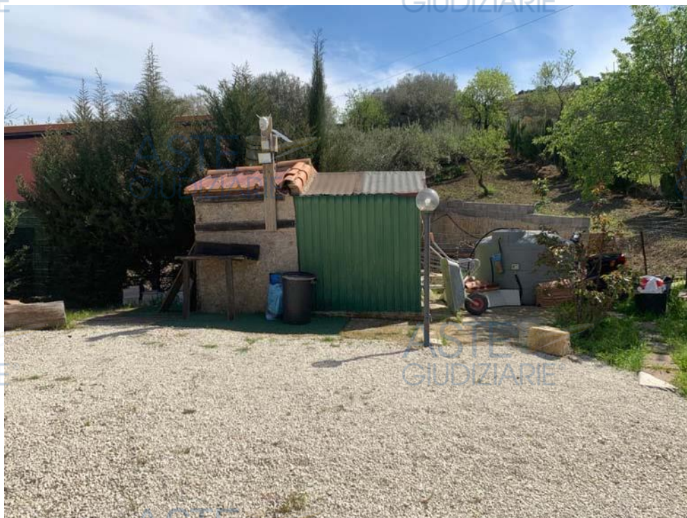
Foto 13 Locale tecnico in precario
