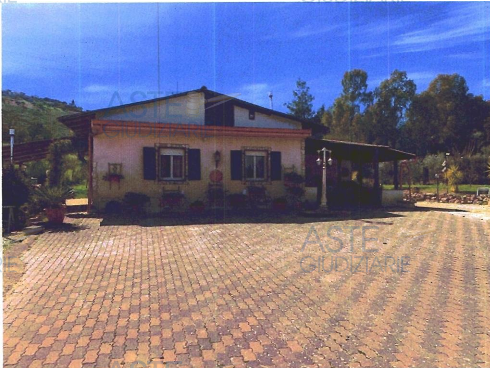
Foto 1 Prospetto lato ingresso
