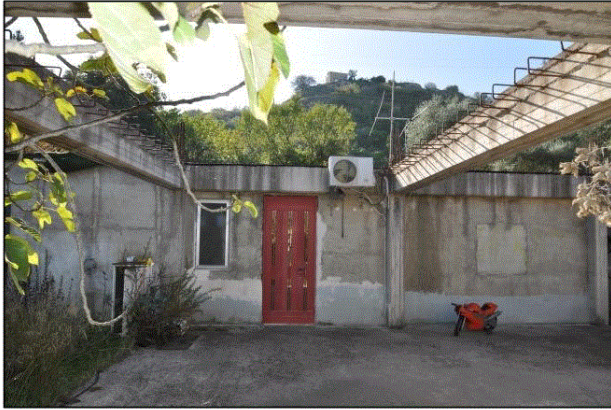
Vista prospetto principale
