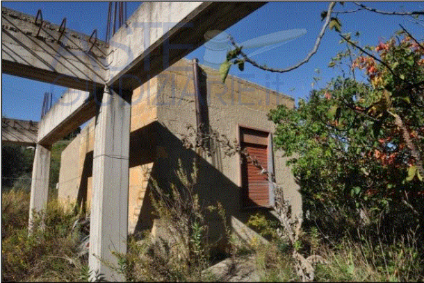
Vista delle due strutture
