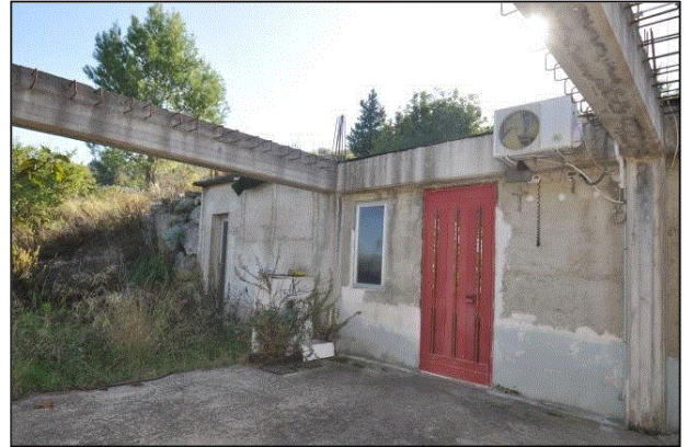
Vista prospetto principale
